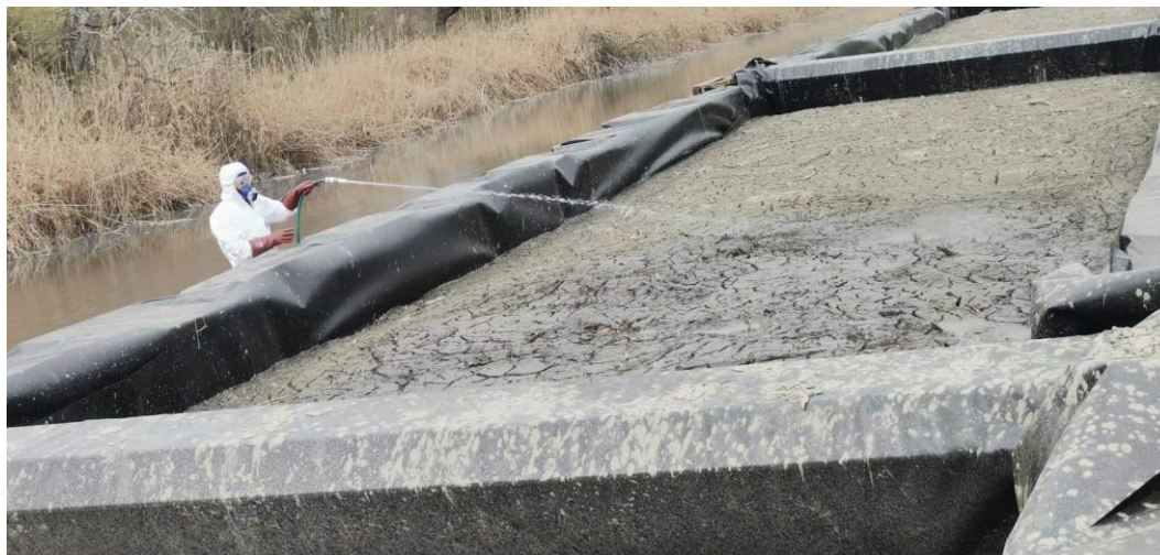
5. sz. ábra: Adalékanyag kézi kijuttatása
